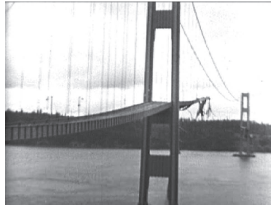
Die eingestürzte erste Tacoma-Narrows-Brücke
