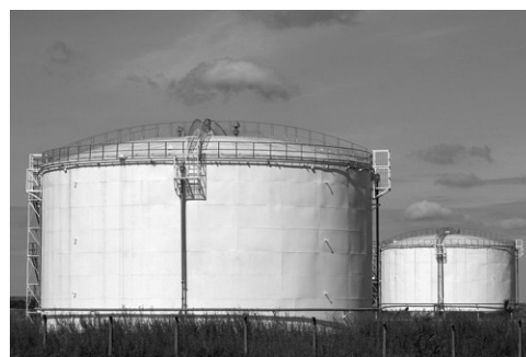
Öl lagert vor der Bearbeitung in Öltanks.
