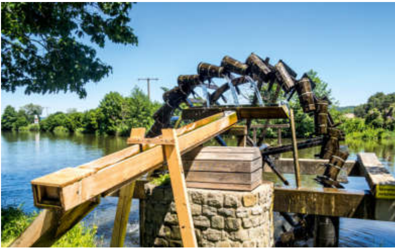
2 | Wasser auf ein höheres Niveau bringen: eine frühe Nutzung von Wasserrädern
