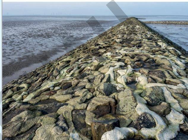
Buhnen sind meist rechtwinklig zur Küste in das Wasser hineingebaute Hindernisse (wand- oder dammartige Bauwerke). Buhnen bestehen meistens aus Holzpfählen, die in den Meeresboden gerammt werden. Das Betreten von Buhnen ist aus Sicherheitsgründen verboten, weil sie in der Regel sehr rutschig sind. Außerdem entwickeln sich im Bereich der Buhnen gefährliche Strömungen.
