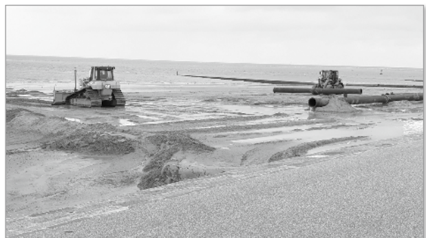
Planierraupen verteilen das Sand-Wasser-Gemisch am Strand.
