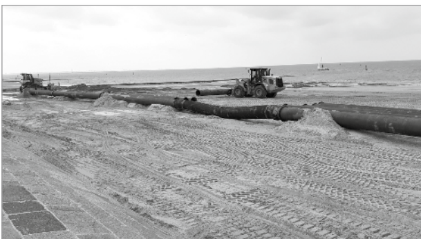
Rohrleitungen transportieren den vom Meeresgrund aufgesaugten Sand zum Strand.
