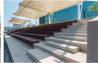
Bedachung einer Tribüne
