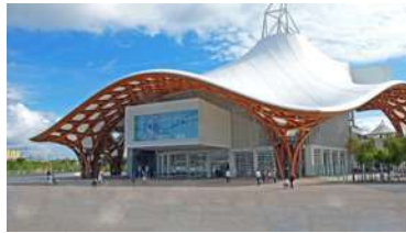
Dach des Centre Pompidou, Metz
