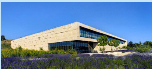
La fabrique à visiter
