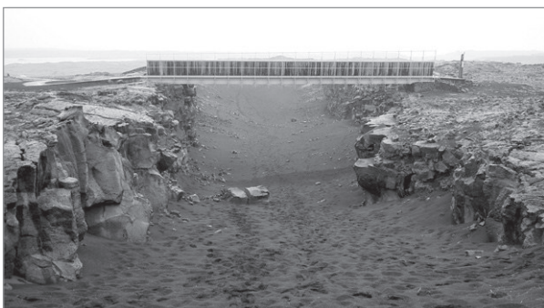
Eine Brücke überspannt den Plattenrand zwischen der Eurasischen und Nordamerikanischen Platte.
