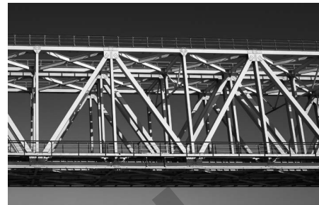
Abb. 2: Stabile Dreiecke werden bei Brücken genutzt.
