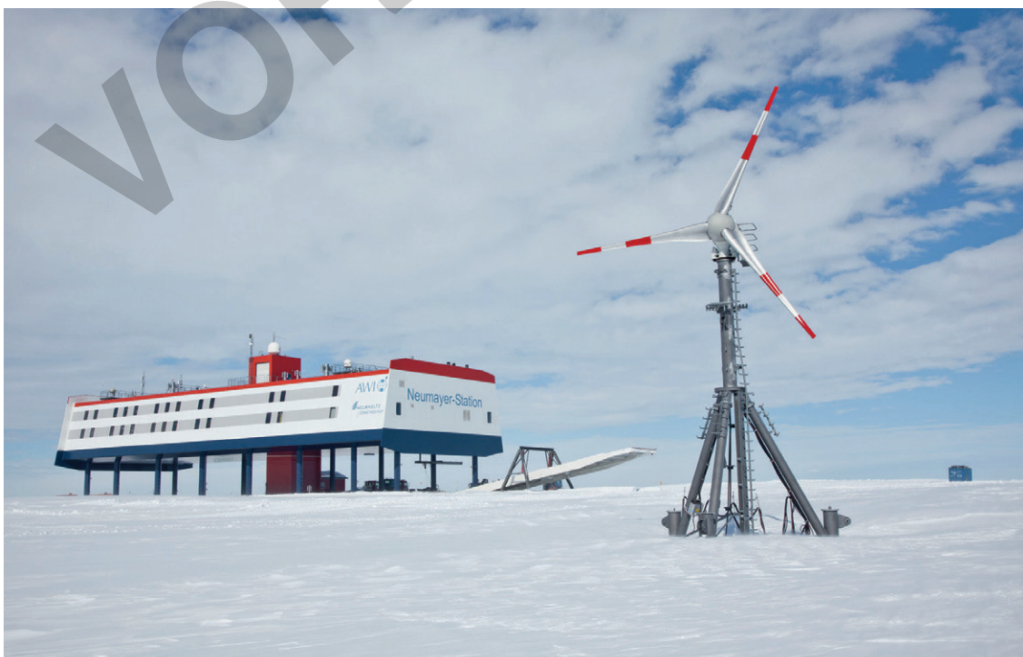
Die Forschungsstation „Neumayer III“. Eine 30-Kilowatt-Windkraftanlage trägt zur umweltfreundlichen Energieversorgung der Station bei.
