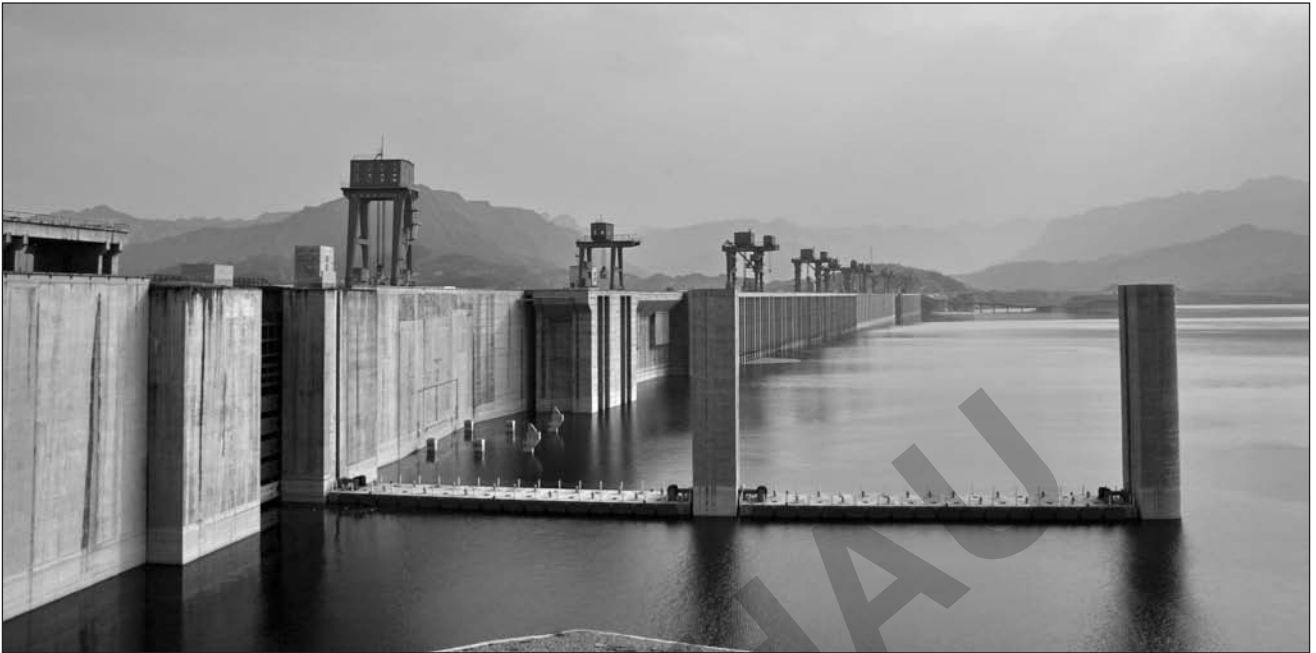
Abb. 1: Talsperre am Jangtsekiang, dem längsten Fluss Chinas
