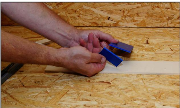
Beim Schneiden darauf achten, dass das Messer gerade geführt wird. Da das PVC sehr weich ist, kann es sonst passieren, dass es von der angezeichneten Linie abweicht.
