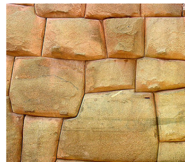
Abbildung 2: Fugenlose Verblockung in einer Inka-mauer
