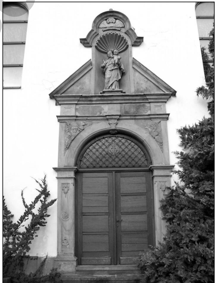
Eingangportal zur ehem. Kapuzinessenkirche
