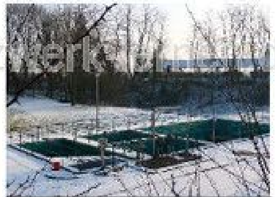
Eine Kläranlage in Heidelberg.
